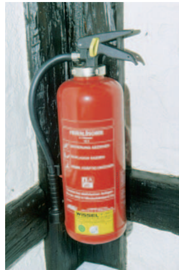
Abb. 8: Der hier bereitgestellte Wasserlöscher (Brandklasse A) ist neben dem Küchenbereich positioniert. Beim Löschen von Fettbränden hätte dies fatale Folgen. Der Wasserdampf würde dann heißes eventuell brennendes Fett/Öl aus dem Becken herausschleudern und Personen gefährden.
