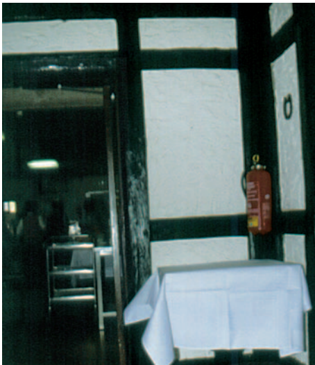
Abb. 8: Der hier bereitgestellte Wasserlöscher (Brandklasse A) ist neben dem Küchenbereich positioniert. Beim Löschen von Fettbränden hätte dies fatale Folgen. Der Wasserdampf würde dann heißes eventuell brennendes Fett/Öl aus dem Becken herausschleudern und Personen gefährden.
